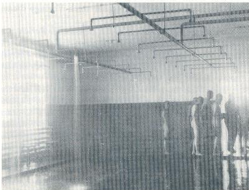
Häftlinge, die soeben geduscht haben, begeben sich in den Trockenraum. "Einige der 50 Duschen sind sichtbar. Die Einrichtung entspricht der Bauzeichnung 3084." (S. 80)
